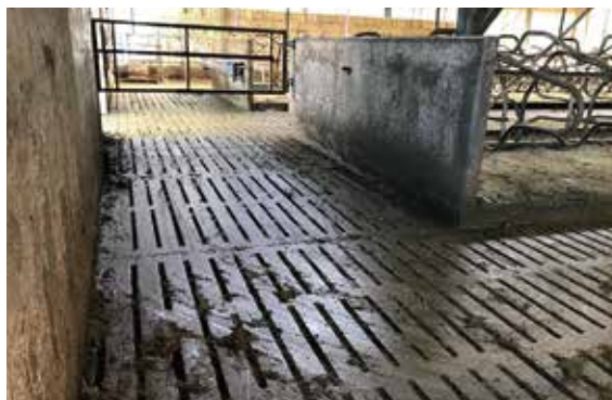
床にスリットが入ったスラットバーン。自動的に糞尿が落ち込む
